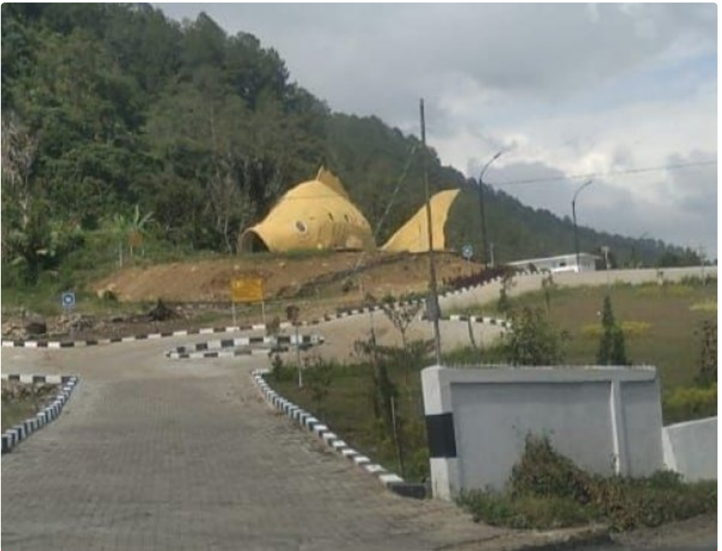
Proyek Pembangunan Ikan Mas Sipolha
